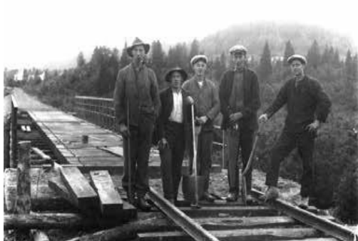
12 Arbeid med Namsosbanen ved Reina bru, 1930.
