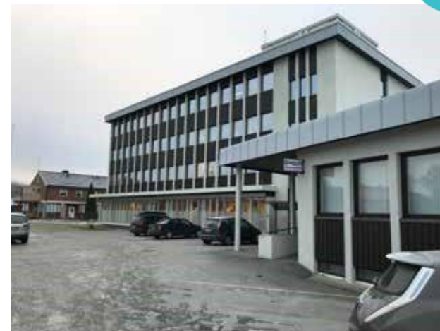
47 Kommunehuset i Overhalla, 2017.
