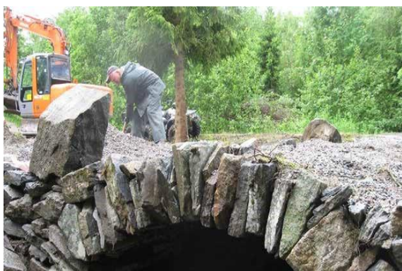
17 Restaurering av Selotten bru, 2008.
